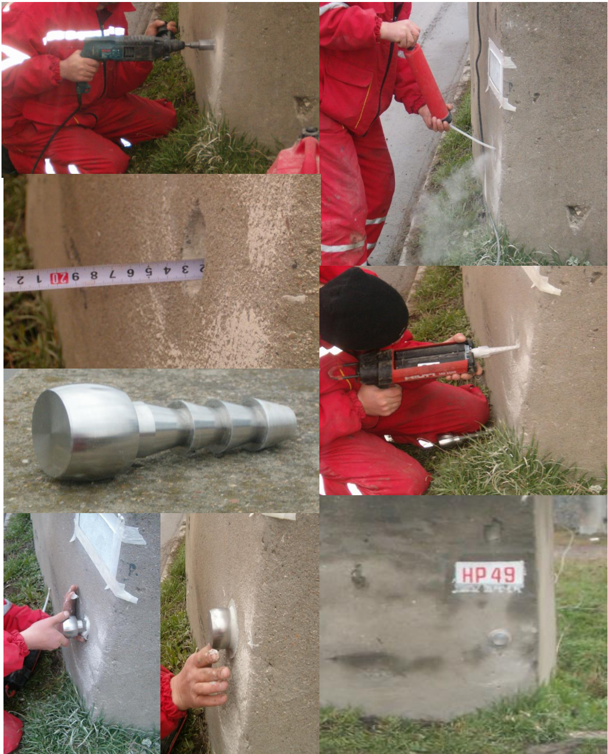
Фигура 4. Етапи от стабилизиране на стенен болт
