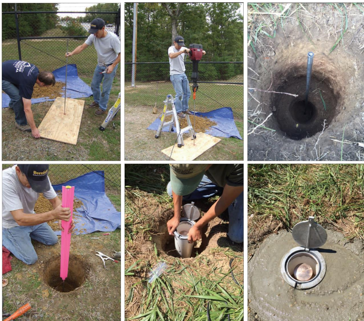
Фигура 2. Етапи от изграждане на дълбочинен репер
