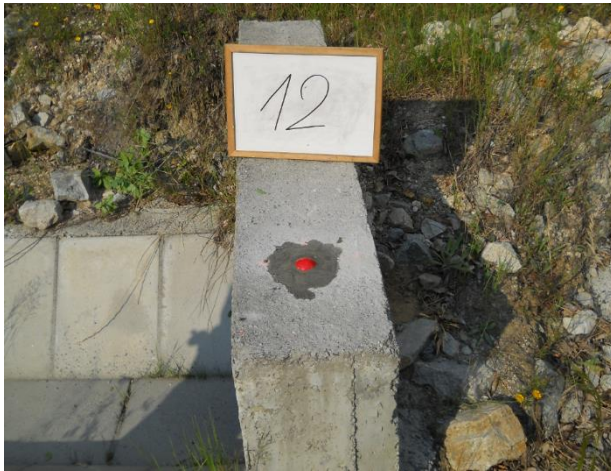
Фигура 6. Стабилизиране на гъбовиден болт в съоръжения
