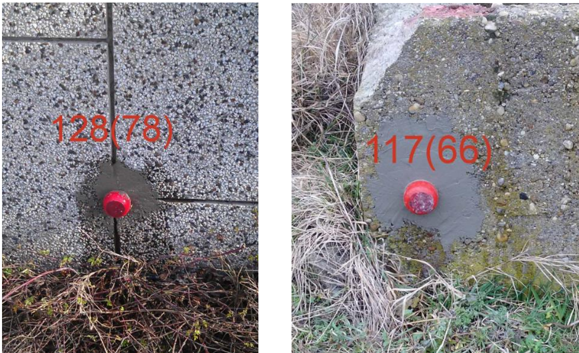
Фигура 5. Стабилизиране на болтове в сгради и съоръжения
