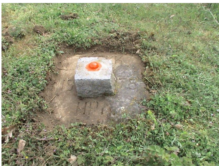
Бетониран каменен блок с гЪбовиден болт (код 52)
