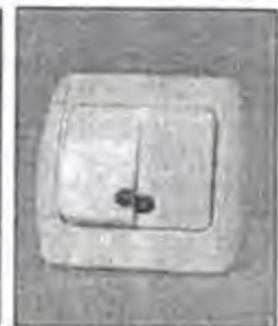
Единичен (вляво) и сериен (вдясно) ключ със светлинен индикатор
